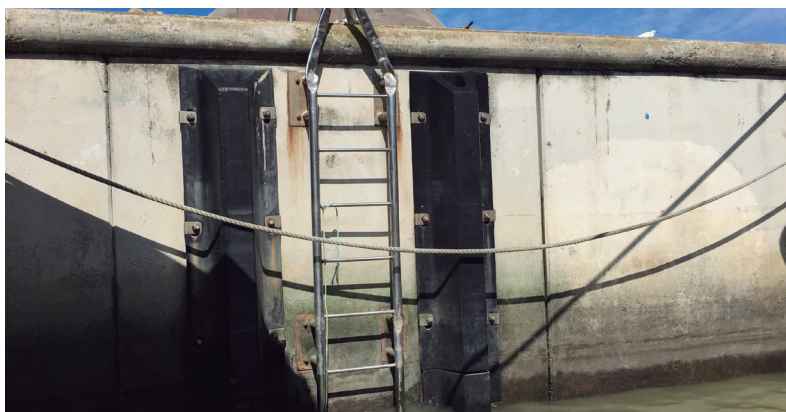
Figura 9. Escala embebida entre defensas
