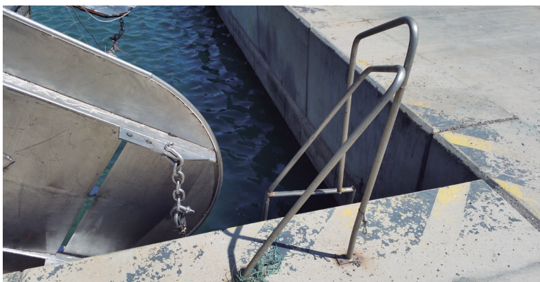
Figura 8. Escala de aluminio deformada
