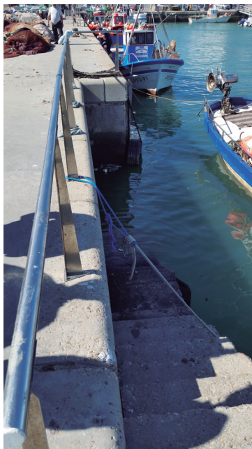
Figura 10. Escalera estructural de hormigón
