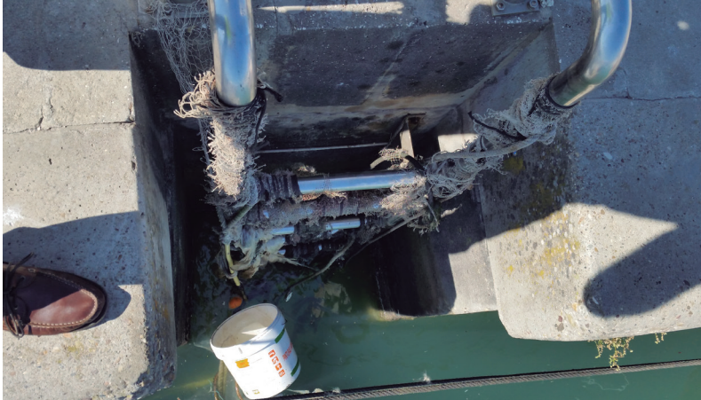
Figura 6. Escala embebida con restos de cabos enrollados
